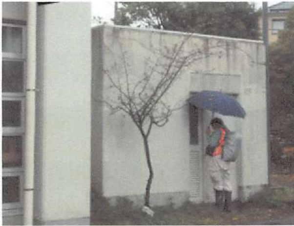
(1) プラダン保管場所(ポンプ室左)
